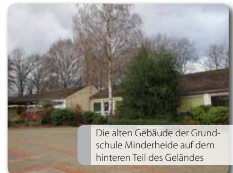
Die alten Gebäude der Grundschule Minderheide auf dem vorderen Teil des Geländes
