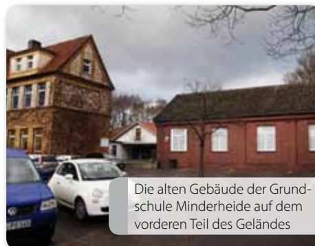
Das neuere Gebäude der Grundschule Minderheide bleibt erhalten.
